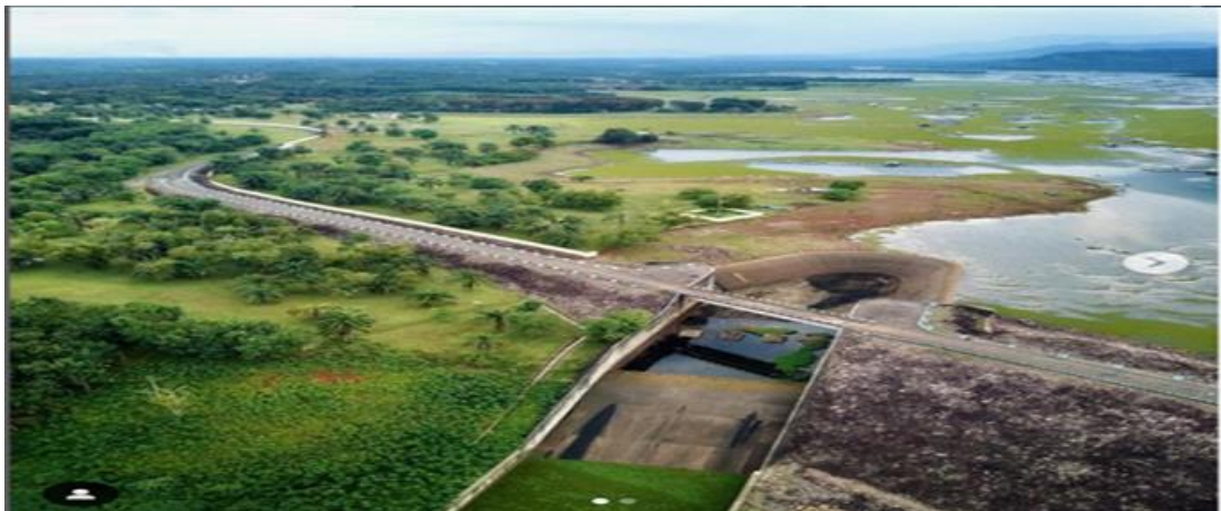
Gambar 2. 56 Foto Infrastruktur Bendungan di Provinsi Lampung
